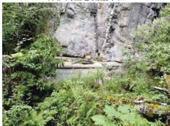
引水隧洞进口
