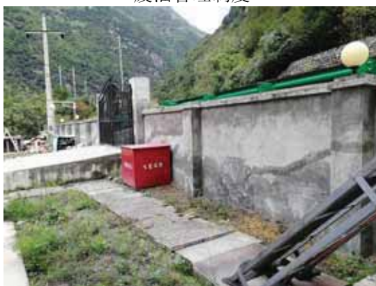
升压站消防沙
