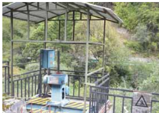
沉沙池冲沙闸 生态流量下泄设施
