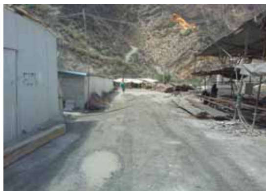
施工场地内洒水保湿
