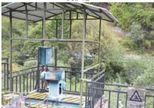
沉沙池冲沙闸兼生态流量下泄口
