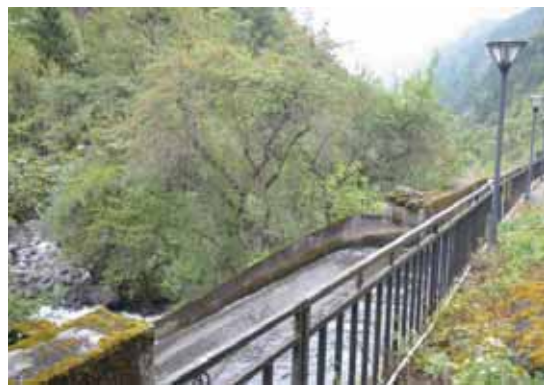
前引渠溢流堰
